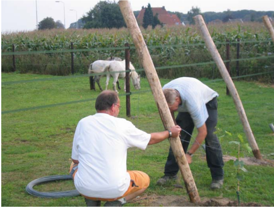
Montage van de steundraden aan de als eerste geplaatste palen.
